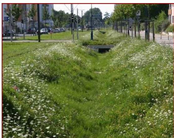
Rów infiltracyjny wzdłuż torów tramwajowych w centrum miasta, Freiburg, Niemcy
