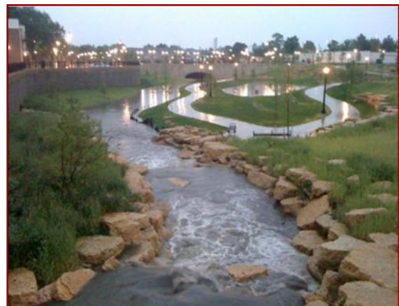
Suchy zbiornik (detention basin) stanowiący część parku przy Boneyard Creek, Champaign, Illinois, USA, w czasie suchej i mokrej pogody
