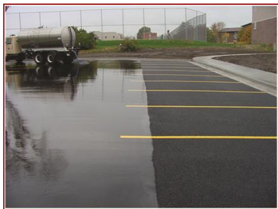
Różnica we wsiąkaniu wody: asfalt tradycyjny (po lewej), asfalt przepuszczalny (po prawej).
