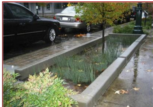
Rów infiltracyjny przy ulicy centrum miasta
