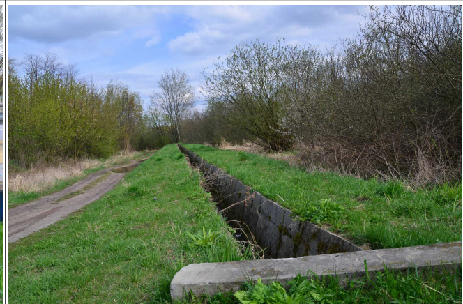
Fot.2. Koryto rowu (odprowadzalnik z przepompowni A0) biegnącego w strefie projektowanego systemu biofiltracyjnego (fot. Beata Naglik).
