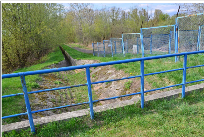
Fot.5. Koryto rowu (odprowadzalnik z przepompowni na kanale A0) – strefa wylotowa (przewidziany do zlikwidowania). Widok od strony istniejącej przepompowni (fot. Beata Naglik).
