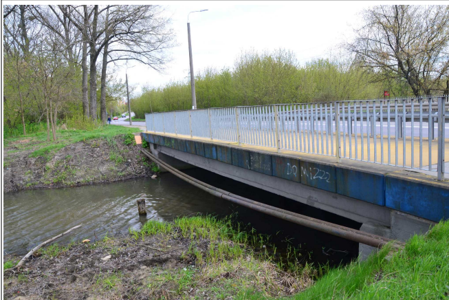
Fot.1. Most na ulicy Suchej – widoczna nisko zawieszona infrastruktura, stanowiąca potencjalne miejsce spiętrzenia przepływu (fot. Beata Naglik).
