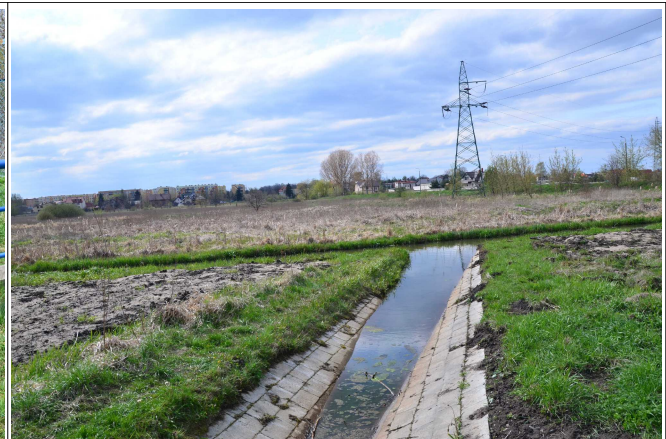
Fot.6. Koryto rowu (odprowadzalnik z przepompowni na kanale A0) – strefa ujścia do rzeki Mlecznej (przewidziany do zlikwidowania). Miejsce wylotu istniejącego odprowadzalnika będzie w przyszłości wykorzystane jako odpływ z systemu SSSB (fot. Beata Naglik).
