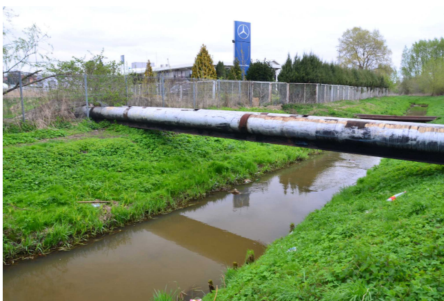
Fot.12. Ciepłociąg biegnący ponad korytem rzeki Mlecznej (fot. Beata Naglik).
