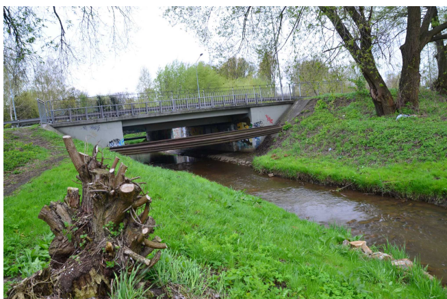
Fot.11. Linia energetyczna i telekomunikacyjna biegnąca ponad korytem rzeki Mlecznej (fot. Beata Naglik).
