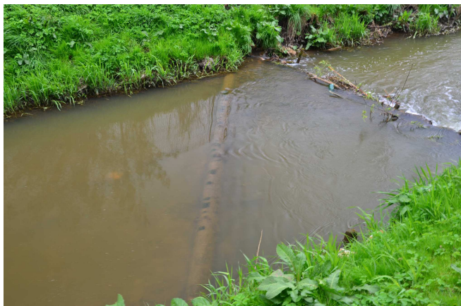
Fot.9. Rurociąg z kablem biegnący w dnie koryta rzeki Mlecznej (fot. Beata Naglik).
