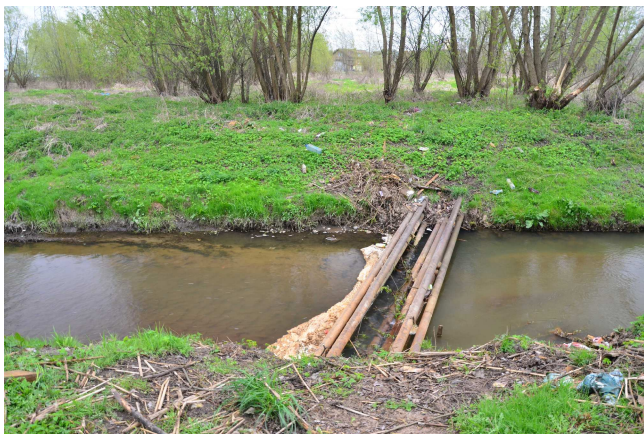
Fot.10. Rurociąg z kablami biegnący ponad korytem rzeki Mlecznej (fot. Beata Naglik).
