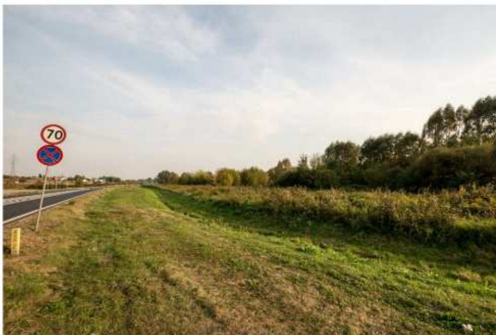
Fot.18. Widok ogólny na obiekt nr 5, Strumień Halinowski i ulicę NSZZ Solidarność.
