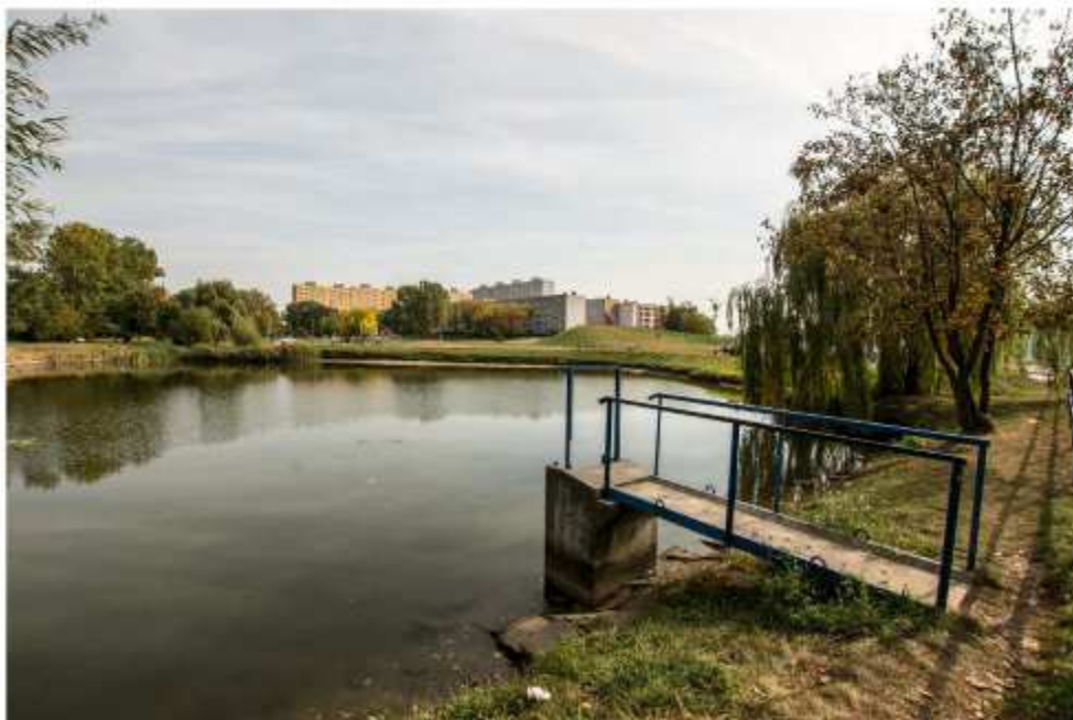
Fot.6. Widok ogólny zbiornika w obiekcie nr 2.
