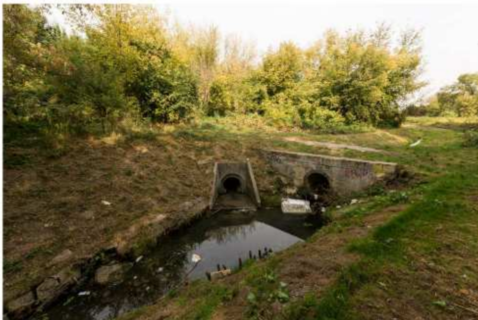
Fot.1. Potok Północny w obrębie obiektu nr 1.
