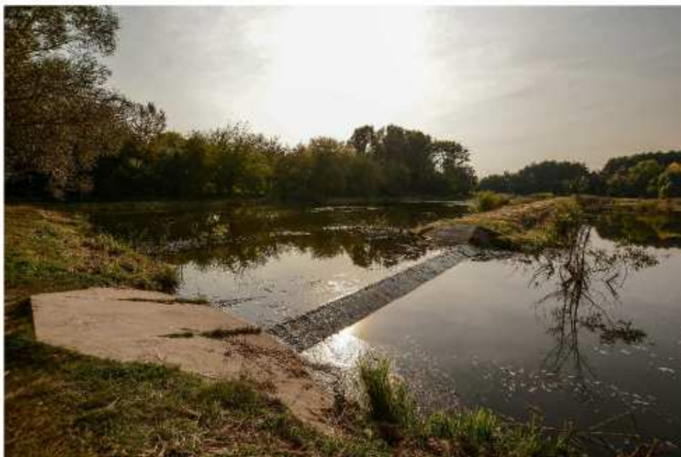
Fot. 13. Zbiorniki odmulające w obiekcie nr 4.
