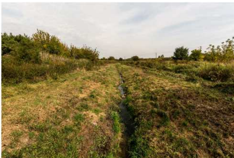
Fot.2. Potok Północny w obrębie obiektu nr 1.
