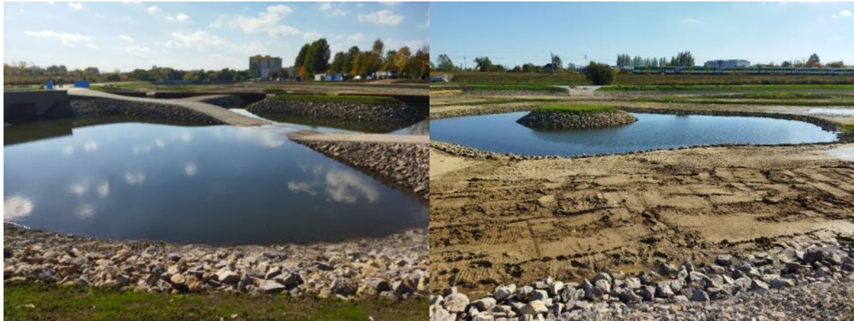
Fot. 3. Potok Północny po budowie (wiosna 2022 r.)
