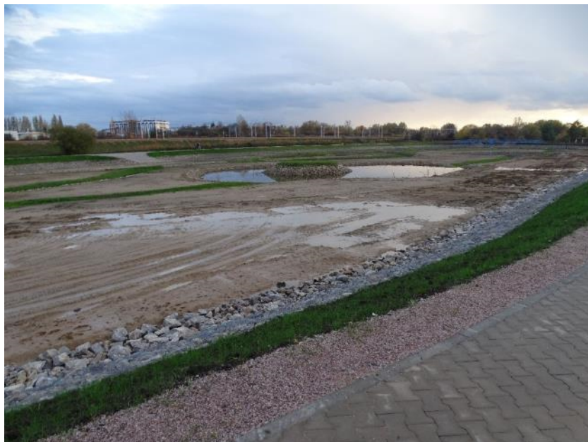
Fot. 18. Potok Północny – oddany jesienią zbiornik wielofunkcyjny (25.10.2022)
