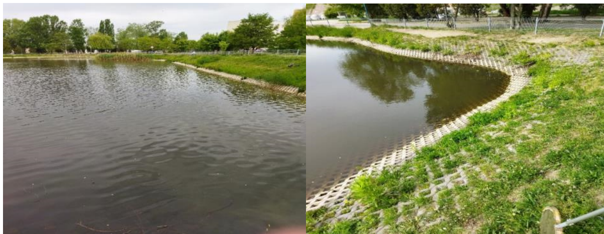
Fot. 7. Zbiornik Ustronie (2022.05.20)
