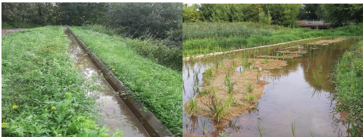
Fot. 5. Kanał A0 – kanał odprowadzający wodę i nasadzenia roślin przy ujściu Kanału A0 do rzeki Mlecznej (lato 2022 r.)
