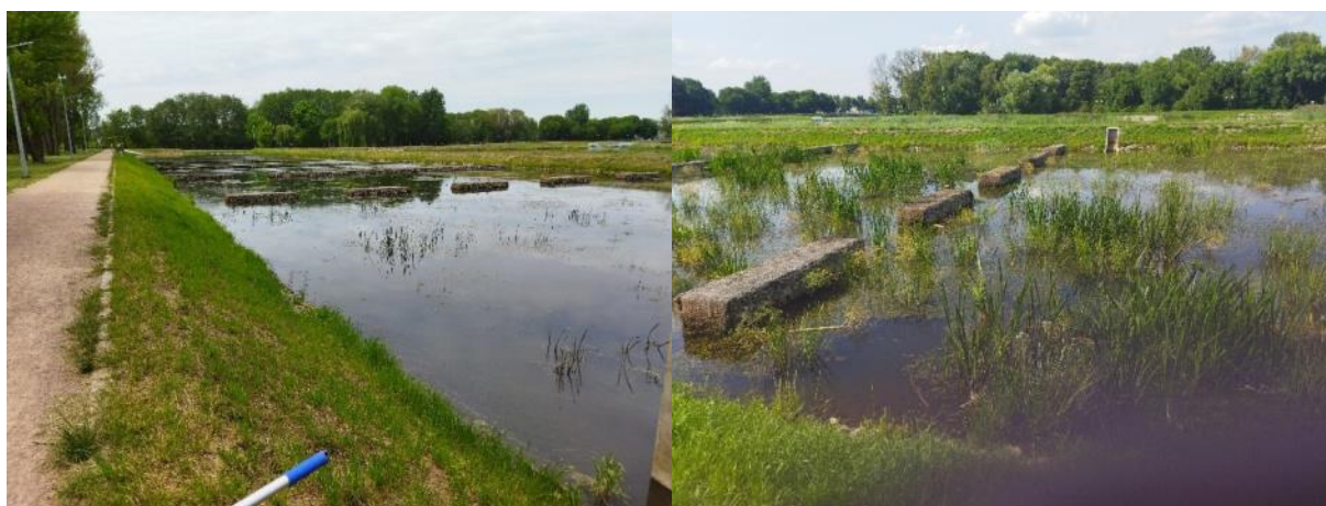
Fot. 1. Stawy kolmatacyjne (kwiecień po lewej i sierpień po prawej, 2022 r.)
