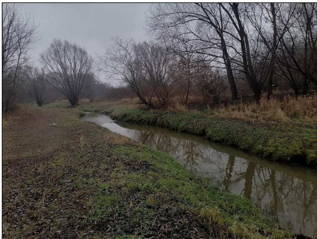
Zdjęcie 17 Koryto rzeki Mlecznej za odcinkiem zremeandryzowanym (układ bystrzy i plos oraz zatok zastoiskowych)
