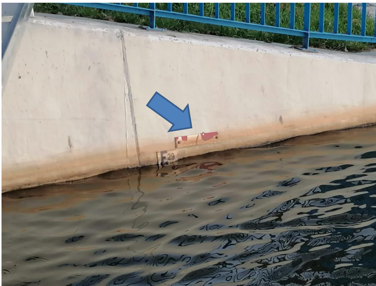
Zdjęcie 3 Oznaczenie maksymalnego poziomu piętrzenia na przyczółku jazu zbiornika Borki
