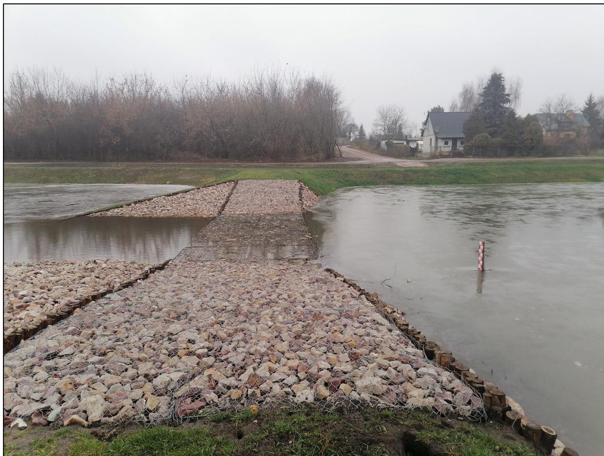
Zdjęcie 9 Jedna z budowli flotacyjno – przelewowych (autor: B. Latoszek)
