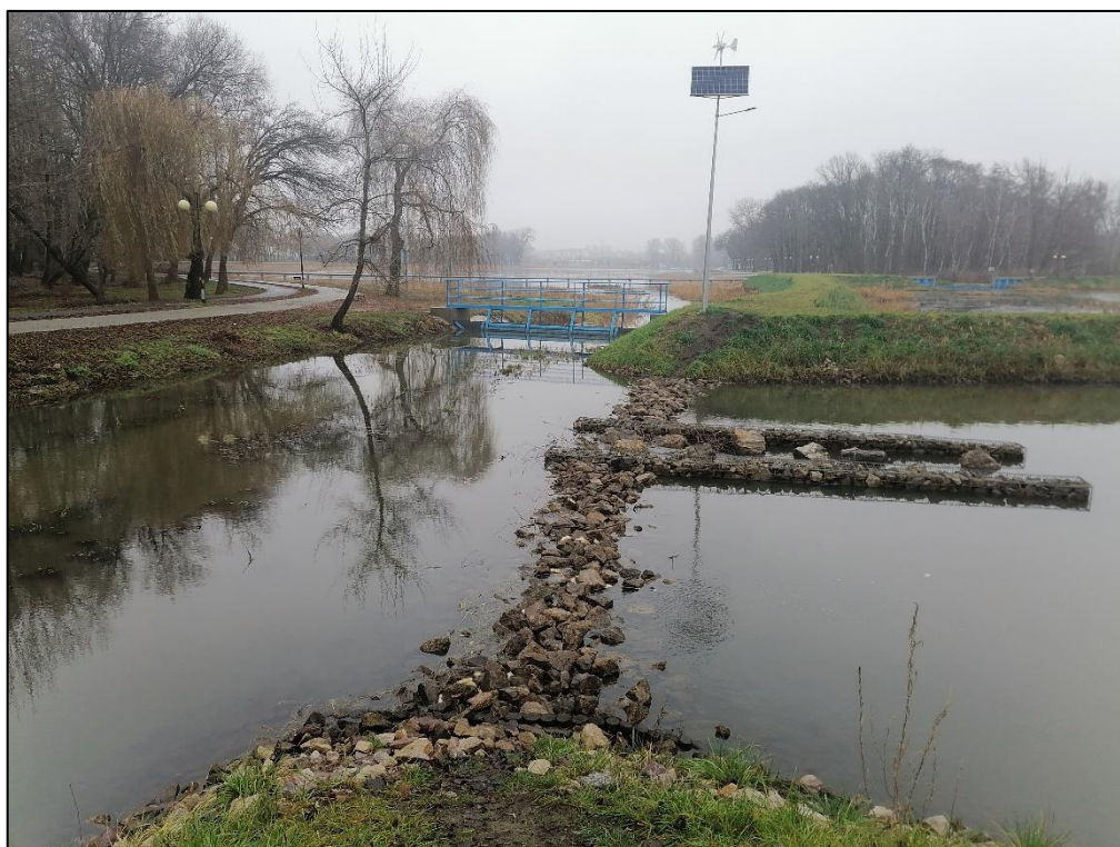
Zdjęcie 5 Staw kolmatacyjny na Zbiorniku/Zalewie Borki
