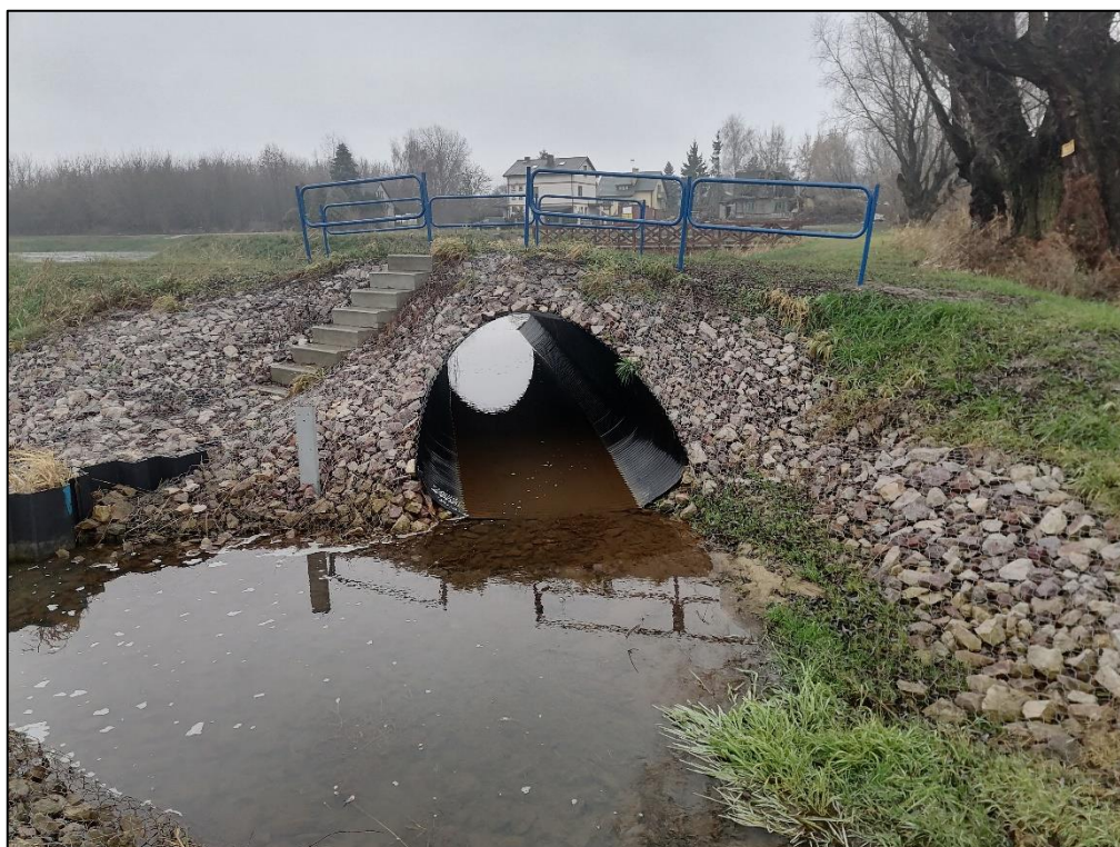
Zdjęcie 10 Przepust na Cerekwiance zasilający polder
