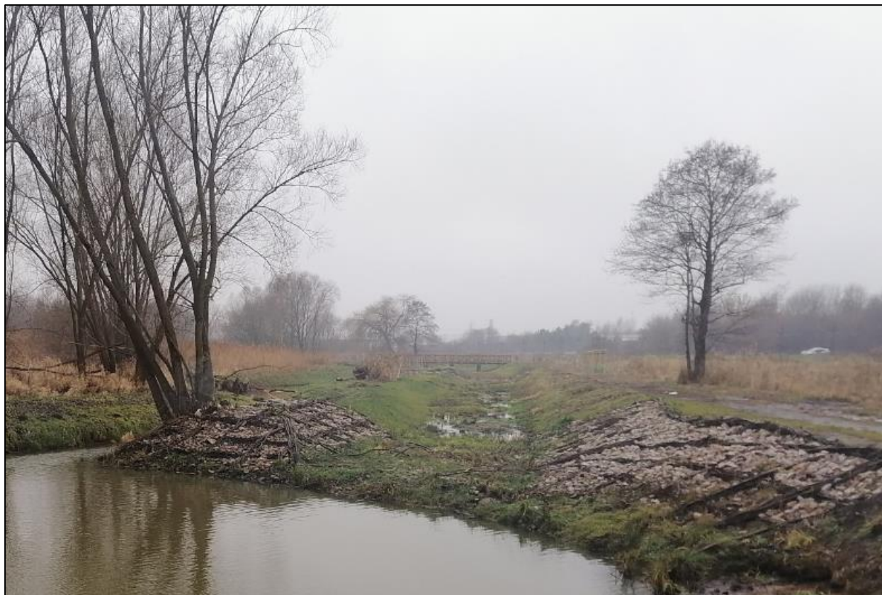
Zdjęcie 7 Koryto wód wielkich wykonane na rzece Mlecznej
