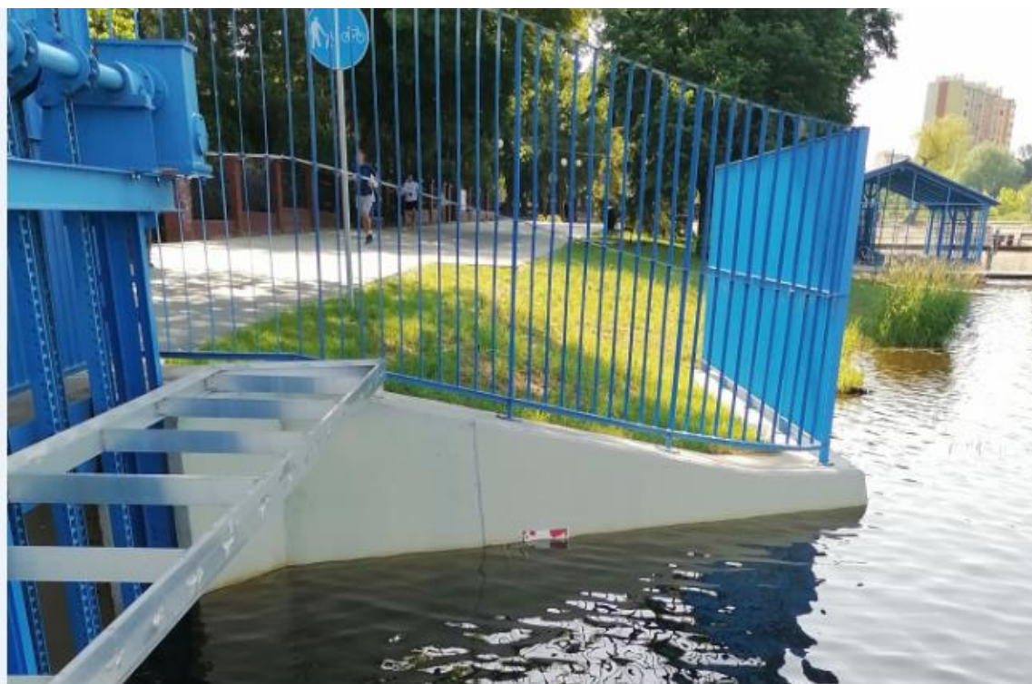
Zdjęcie 5 Wodowskaz zlokalizowany przy napływie na jaz główny na jednej ze skarp
