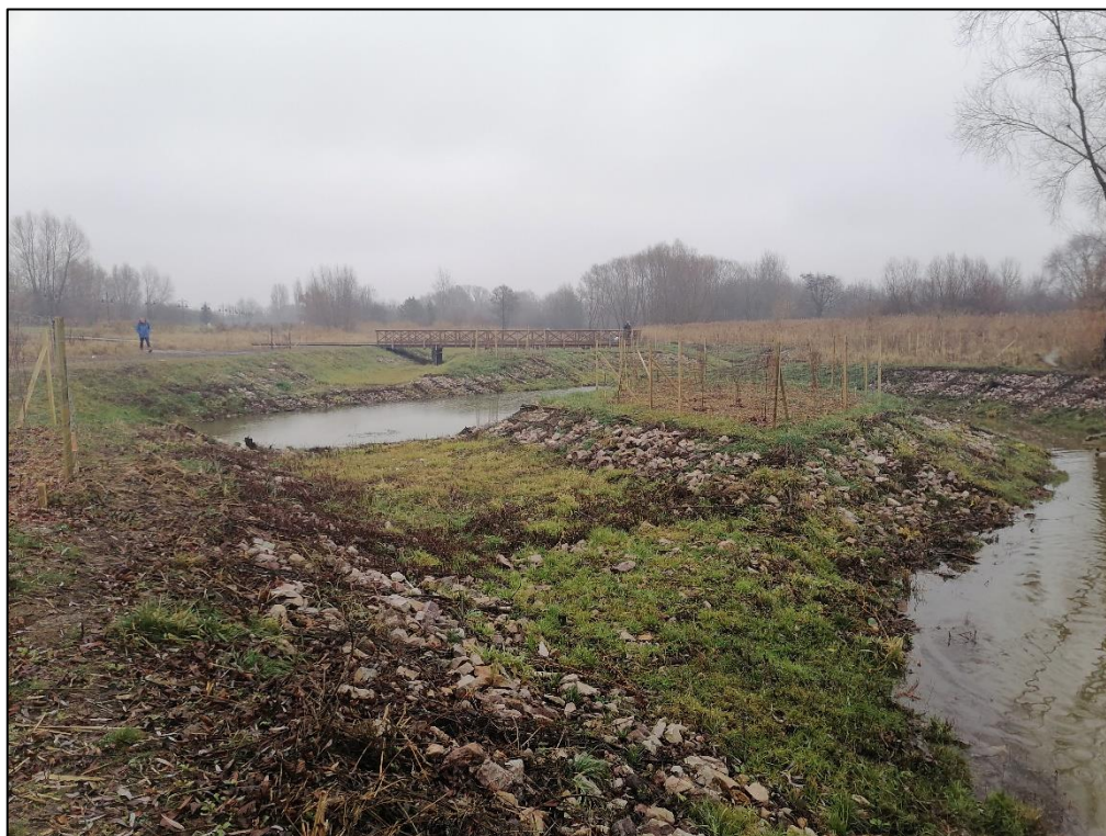
Zdjęcie 15 Widok na kompleks sztucznych zatok zastoiskowych z umocnieniem brzegów faszynowo-kamiennym rzeki Mleczej – odcinek zremeandryzowany
