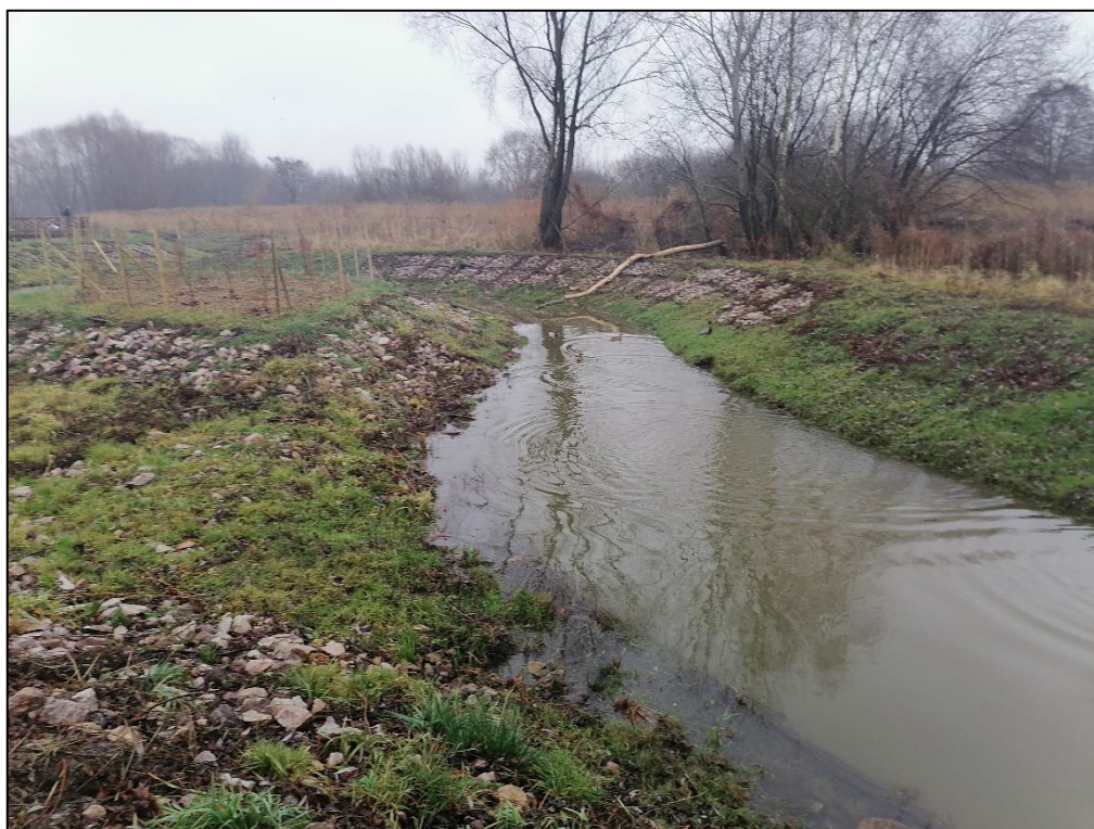
Zdjęcie 14 Widok na umocnienia brzegów faszynowo-kamiennych – odcinek zremeandryzowany
