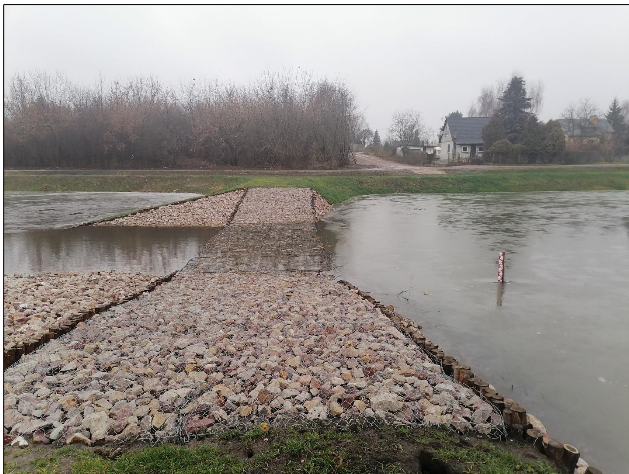
Zdjęcie 3 Jedna z budowli flotacyjno – przelewowych (autor: B. Latoszek)
