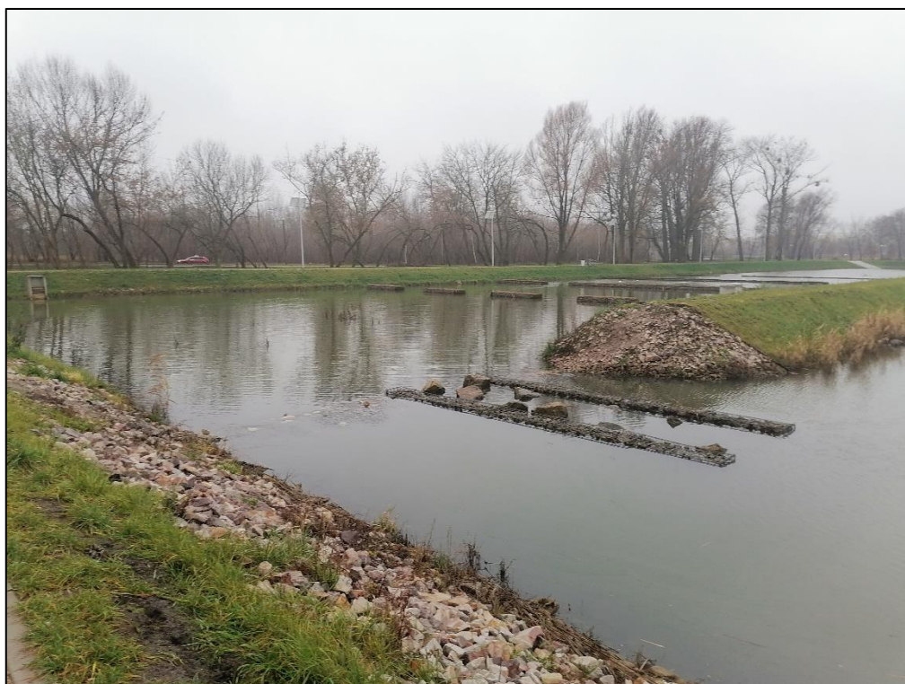
Zdjęcie 3 Staw kolmatacyjny na Zbiorniku/Zalewie Borki
