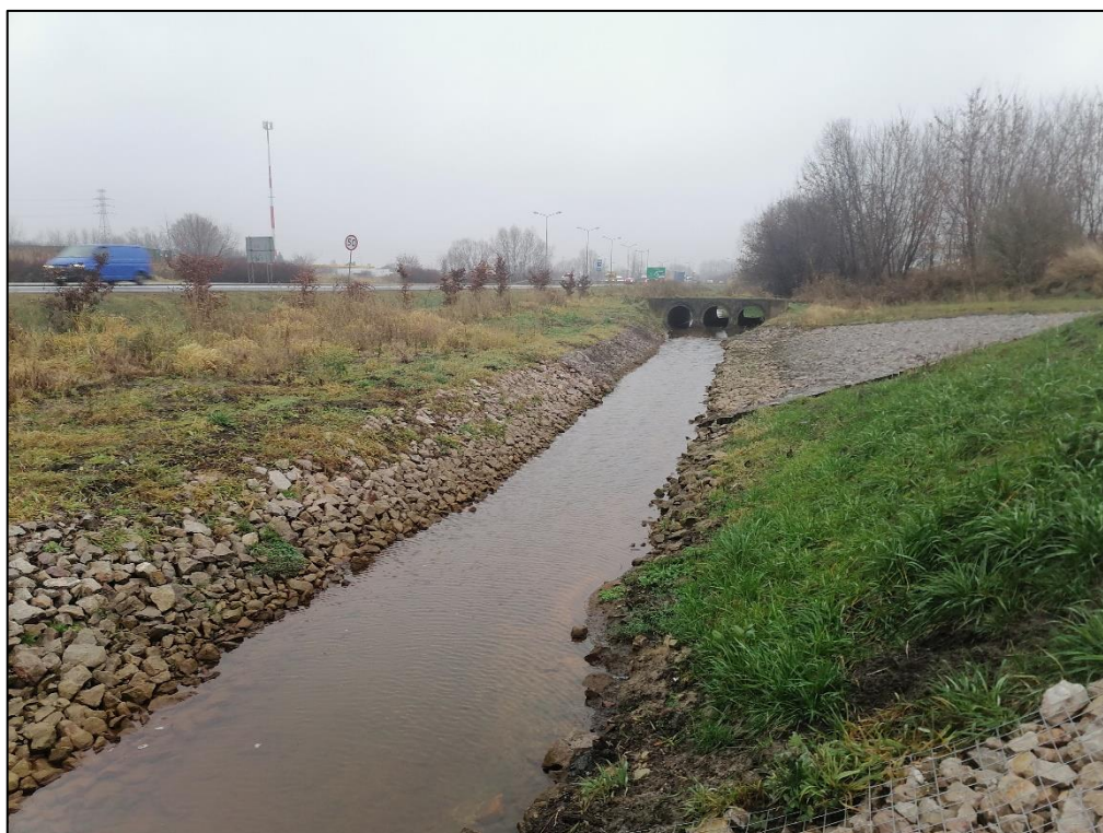
Zdjęcie 7 Przepust dolny na Cerekwianie – dopływ z polderu zalewowego – widok od strony napływu wód
