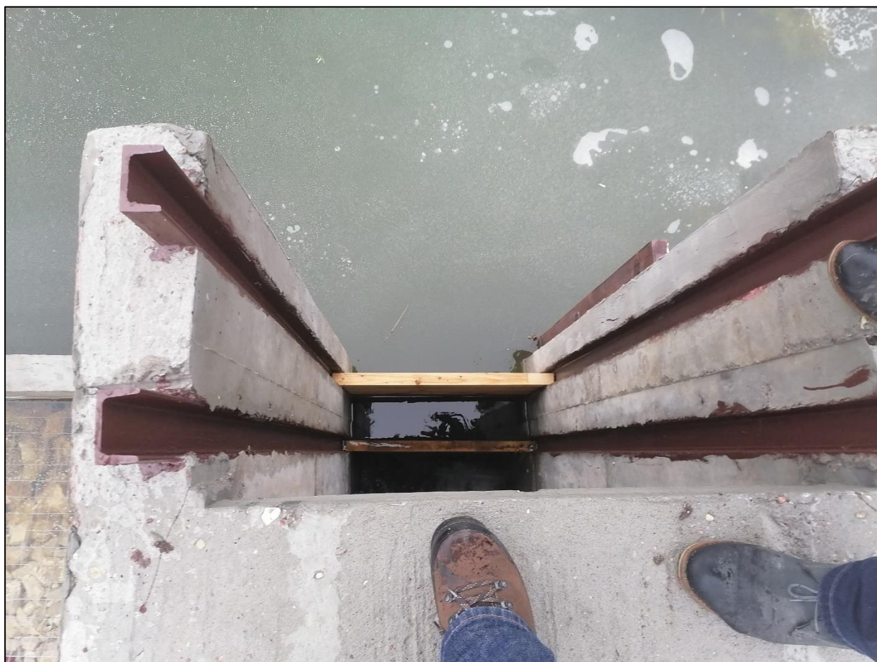
Zdjęcie 10 Żelbetowy mnich spustowy DN 600mm (autor: B. Latoszek)
