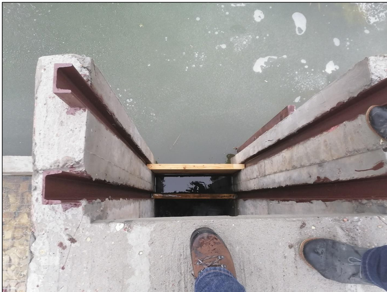
Zdjęcie 4 Żelbetowy mniach spustowy DN 600mm (autor: B. Latoszek)
