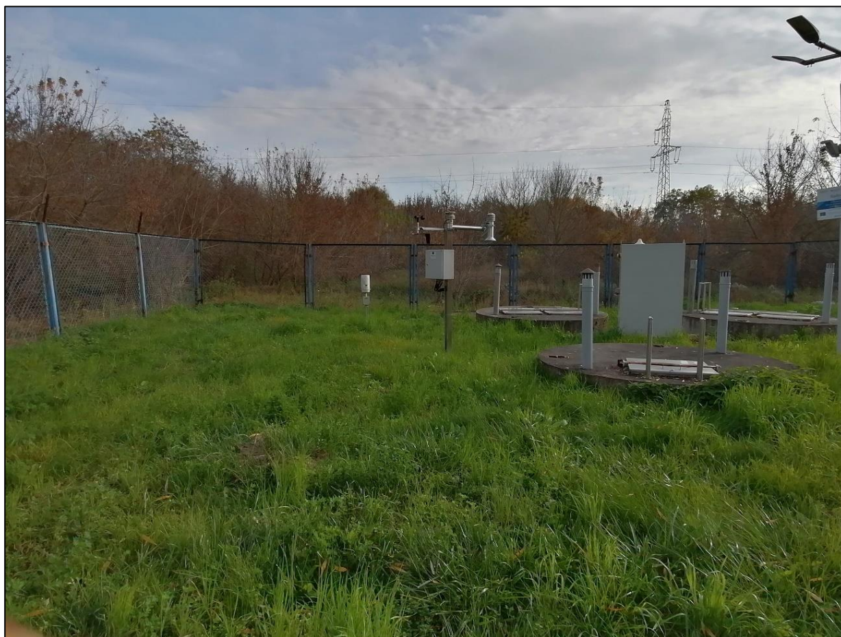
Zdjęcie 5 Stacja pogodowa na terenie pompowni
