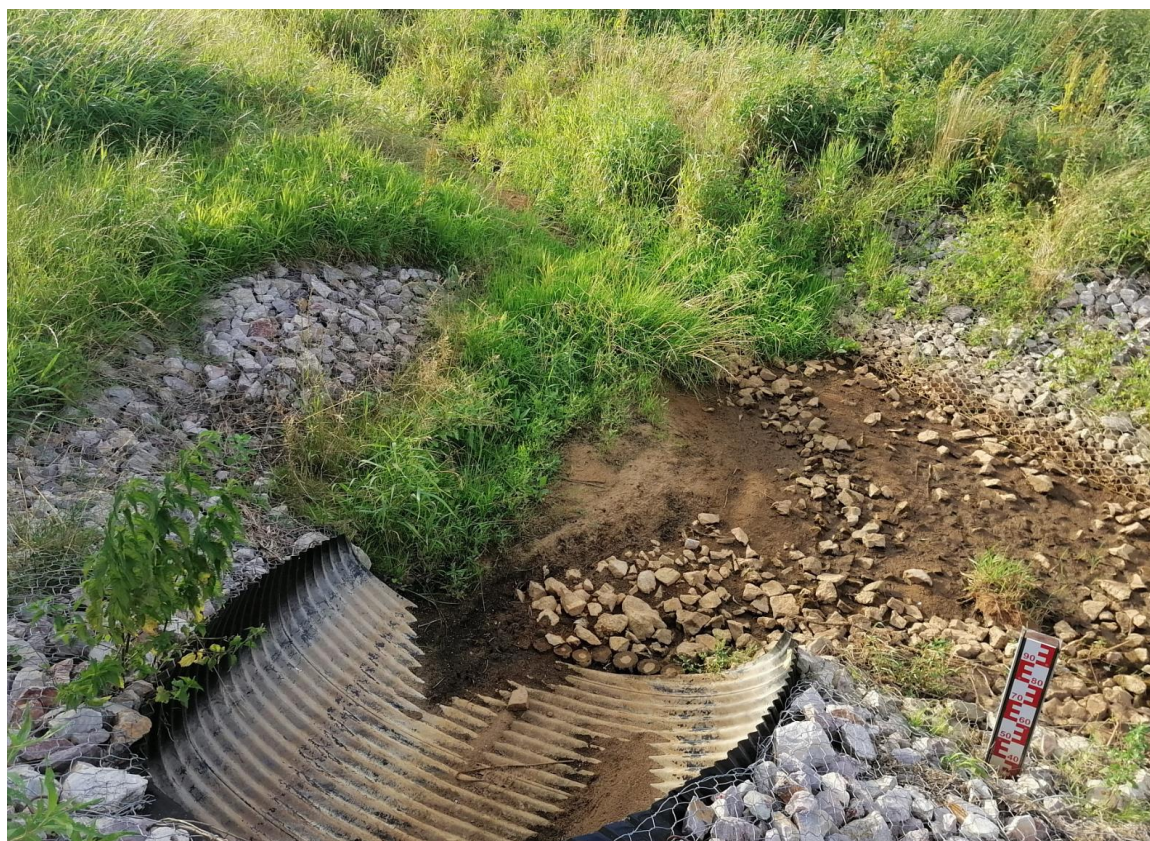
Zdjęcie 15 Przepust zasilający polder zalewowy na Cerekwiance w czasie prowadzenia pomiarów
