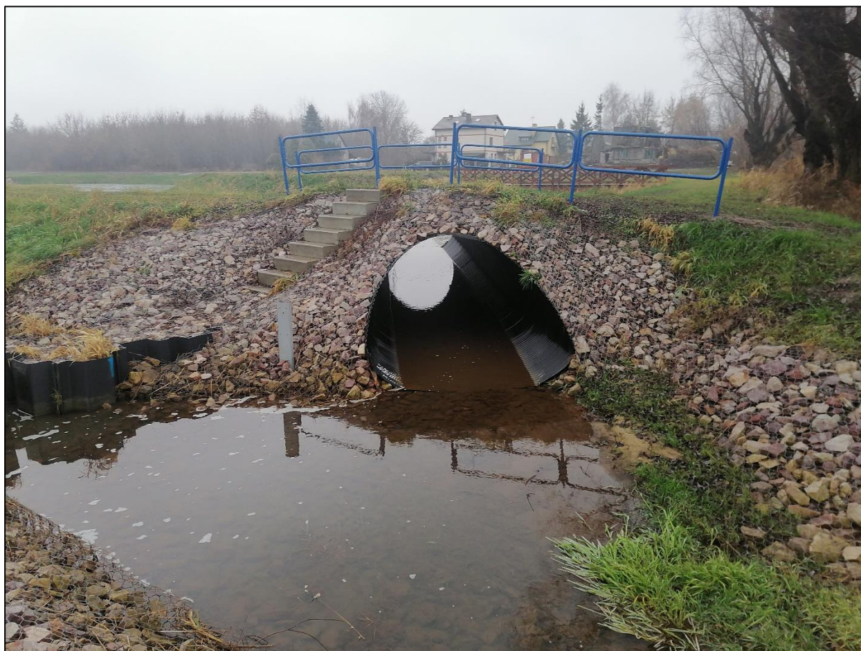
Zdjęcie 2 Budowla wlotowa do polderu zalewowego na rzece Cerekwiance (autor: B.Latoszek)
