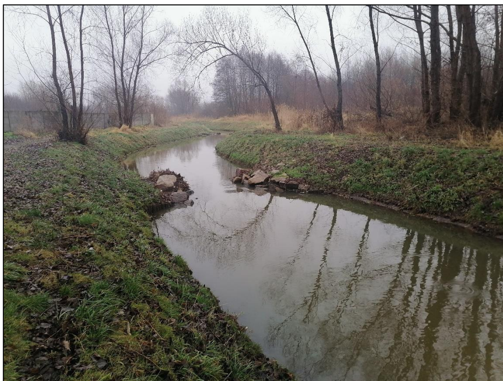
Zdjęcie 12 Płoso na korycie rzeki Mlecznej przed odcinkiem zremeandryzowanym (układ bystrzy i płos oraz zatok zastoiiskowych)
