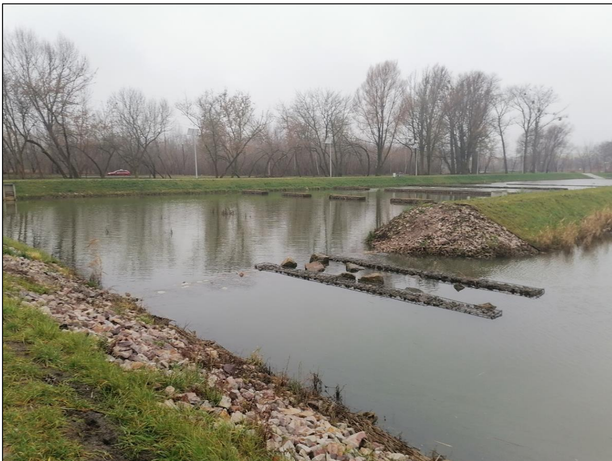
Zdjęcie 2 Widok na staw kolmatacyjny (autor: B.Latoszek)
