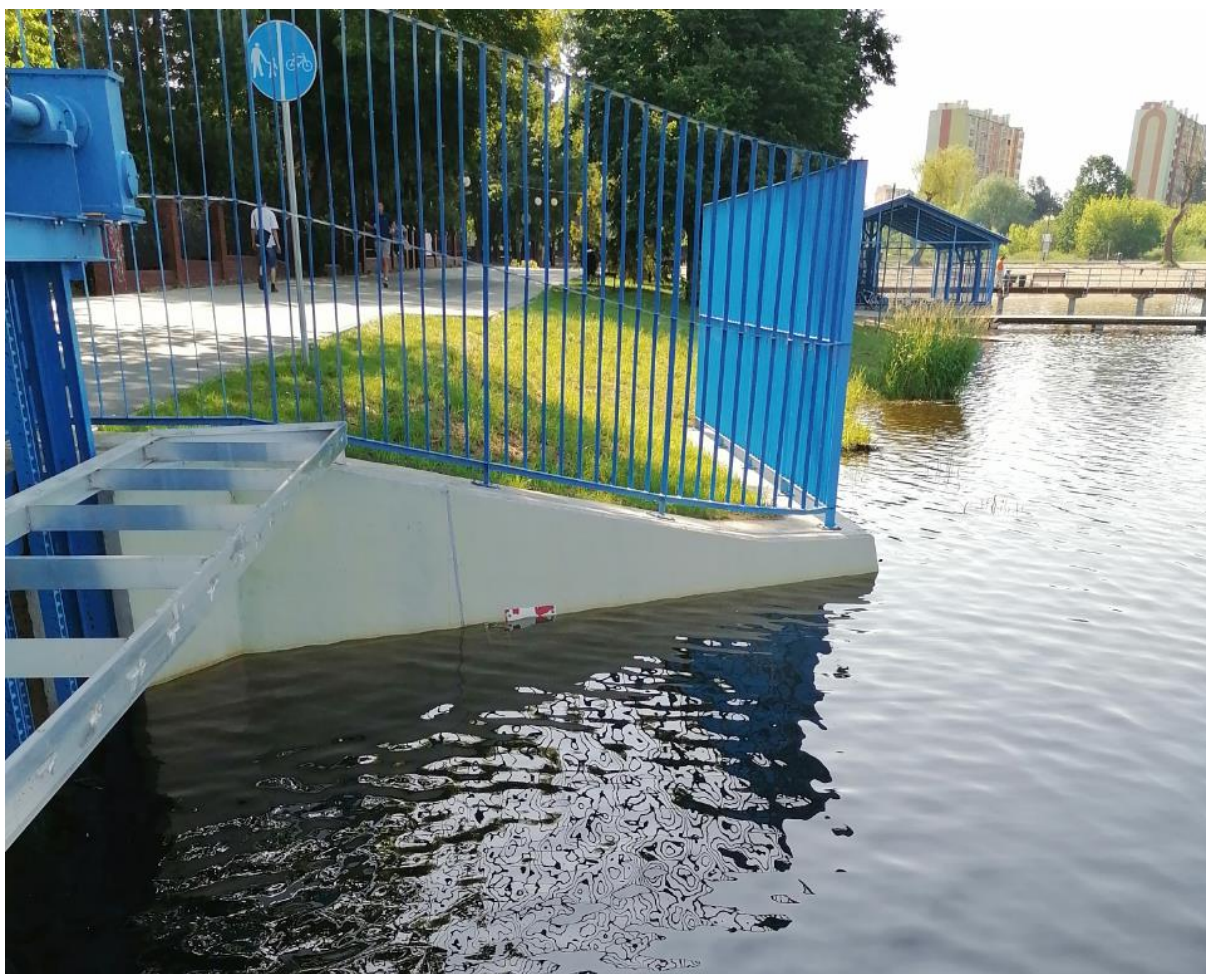
Zdjęcie 10 Miejsce montażu urządzenia pomiarowego w rejonie jazu Zalewu Borki
