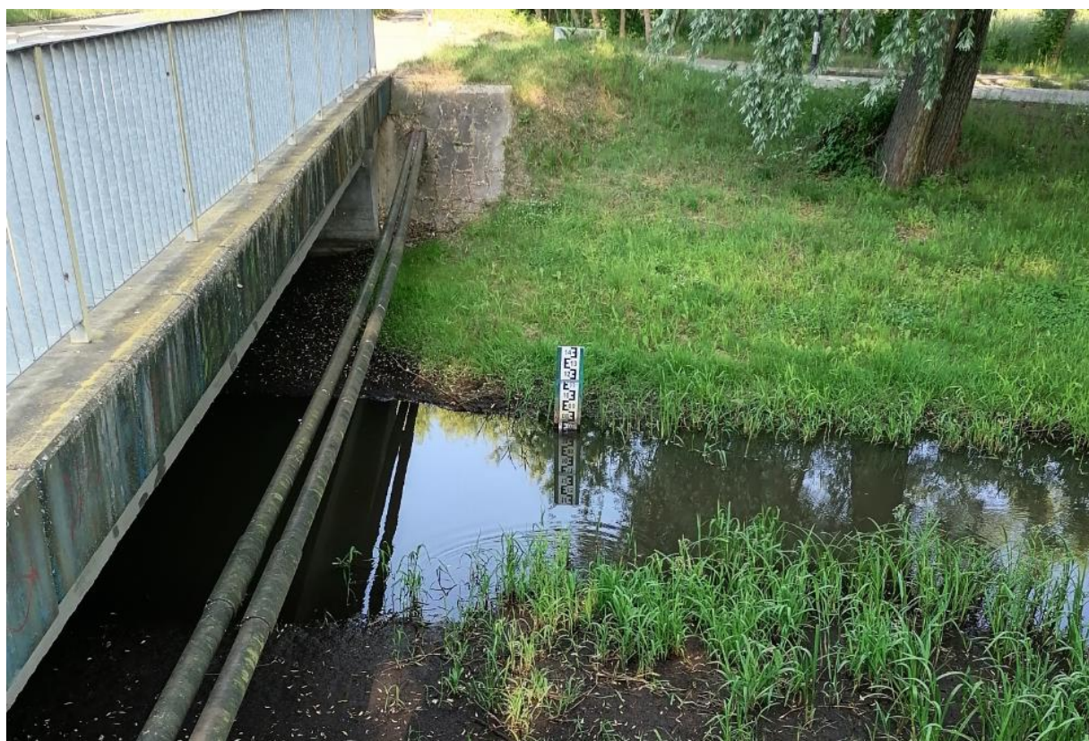
Zdjęcie 4 Miejsce prowadzanego pomiaru D_01 (odpływ)
