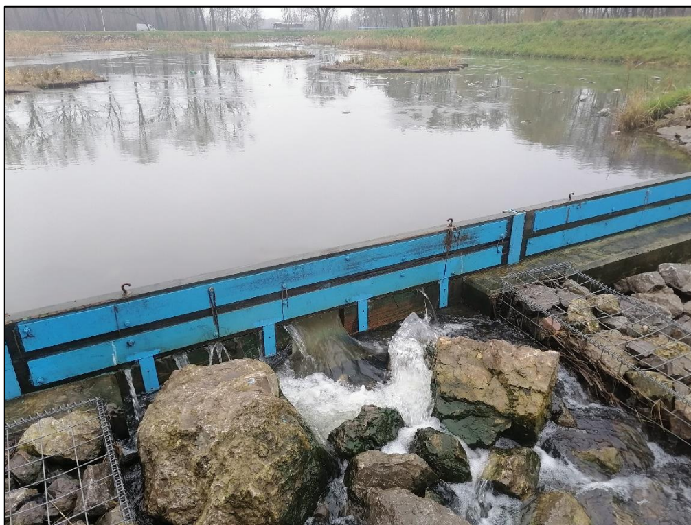
Zdjęcie 1 Staw kolmatacyjny na Zbiorniku/Zalewie Borki
