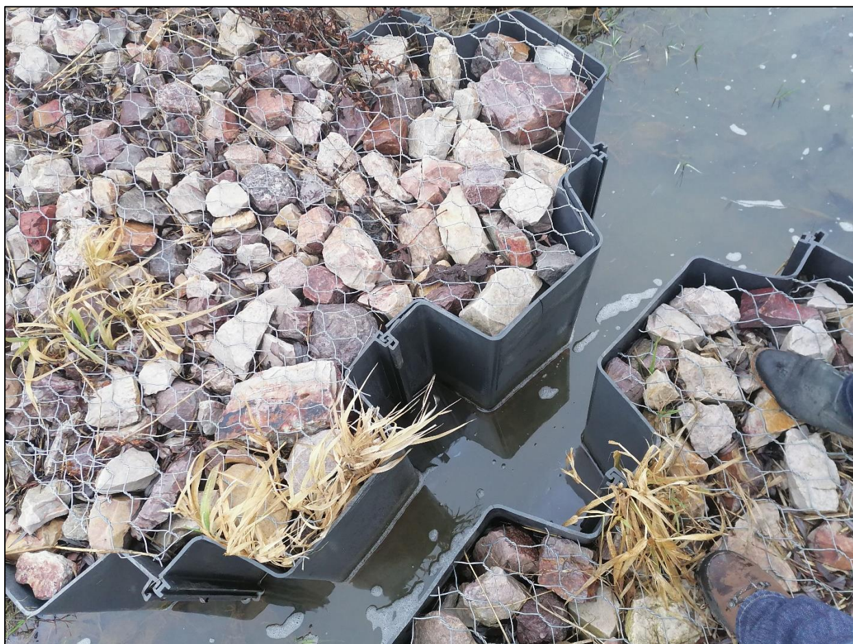
Zdjęcie 7 Szczelina kalibrująca przepływ w korycie rzeki Cerekwianki (autor: B.Latoszek)
