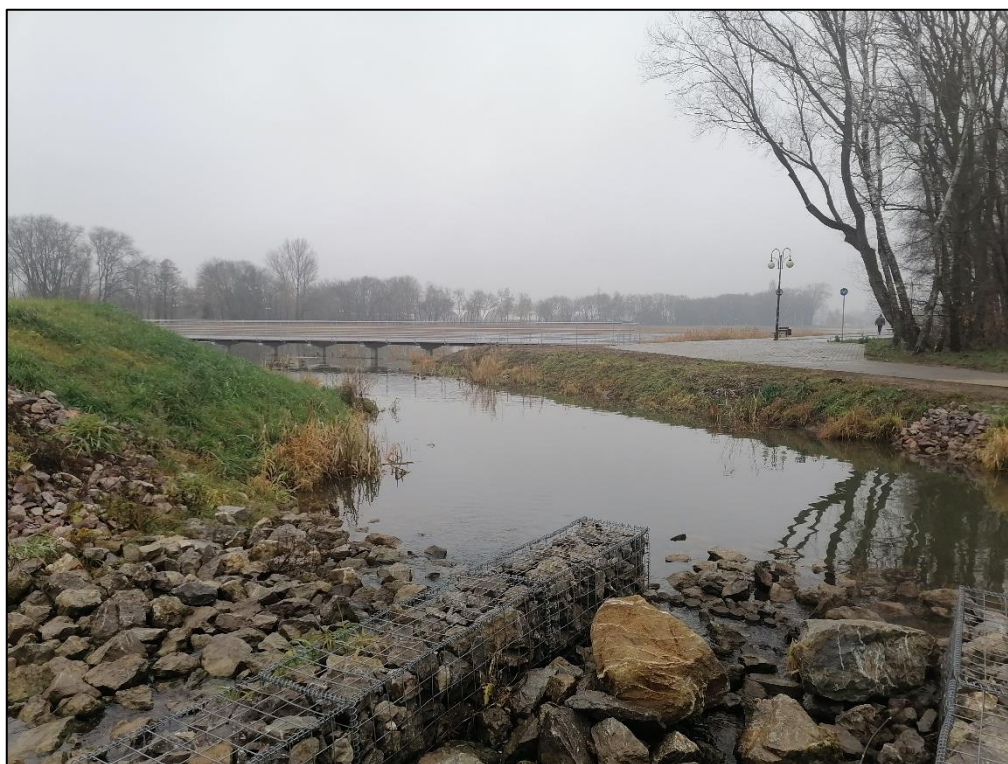
Zdjęcie 2 Staw kolmatacyjny na Zbiorniku/Zalewie Borki
