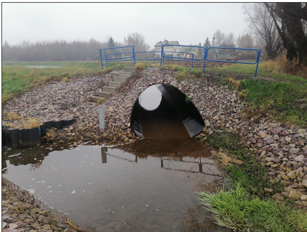
Zdjęcie 8 Budowla wlotowa do polderu zalewowego na rzece Cerekwiance (autor: B.Latoszek)
