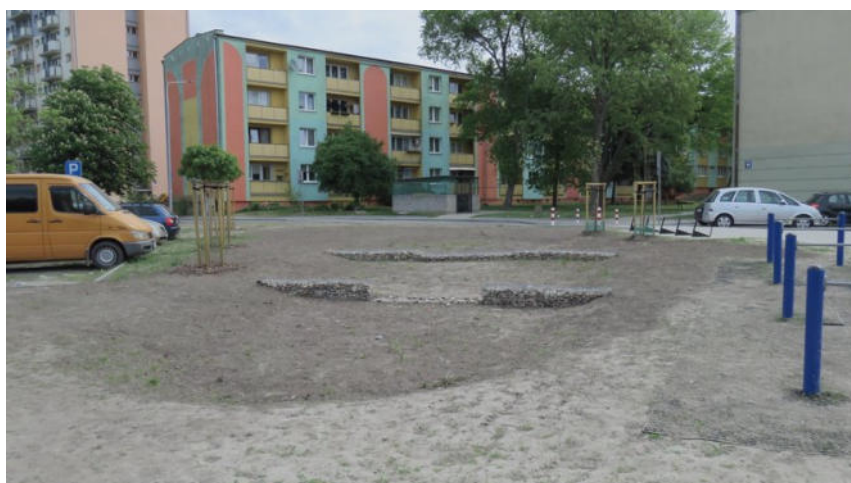
Fot. 28. Niecki zatrzymujące wody opadowe na Placu Bema.
