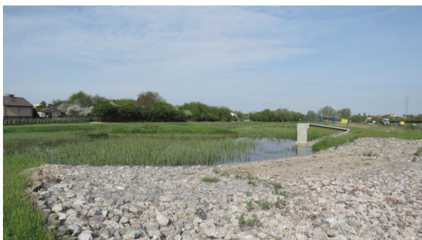
Fot. 23. Przelew z koszy kamiennych pomiędzy zbiornikami.
