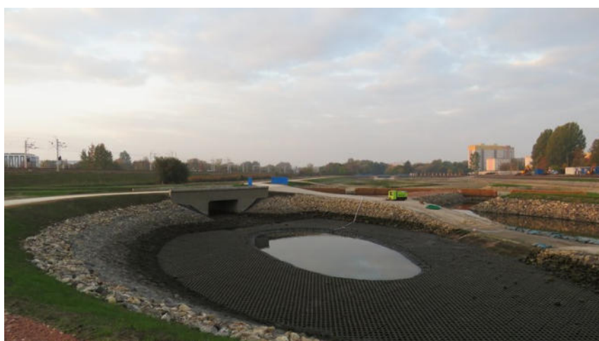
Fot. 26. Osadnik po zakończonej budowie.
