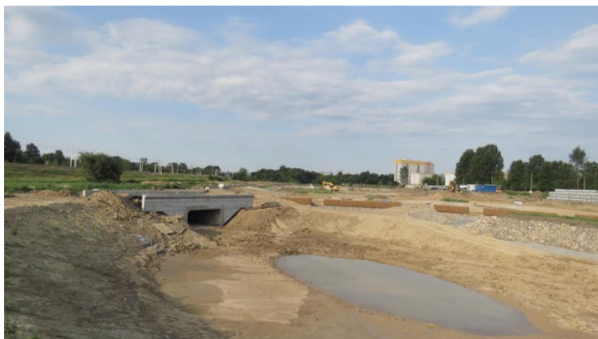
Fot. 25. Czasza zbiornika w trakcie prac ziemnych.
